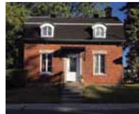
3257, boulevard Lévesque Ouest
