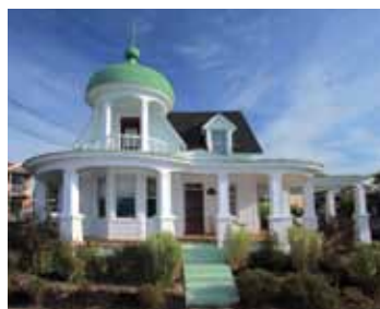
4495, boulevard Lévesque Ouest
