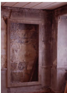
Vestiges d'une armoire encastree dans le mur.
