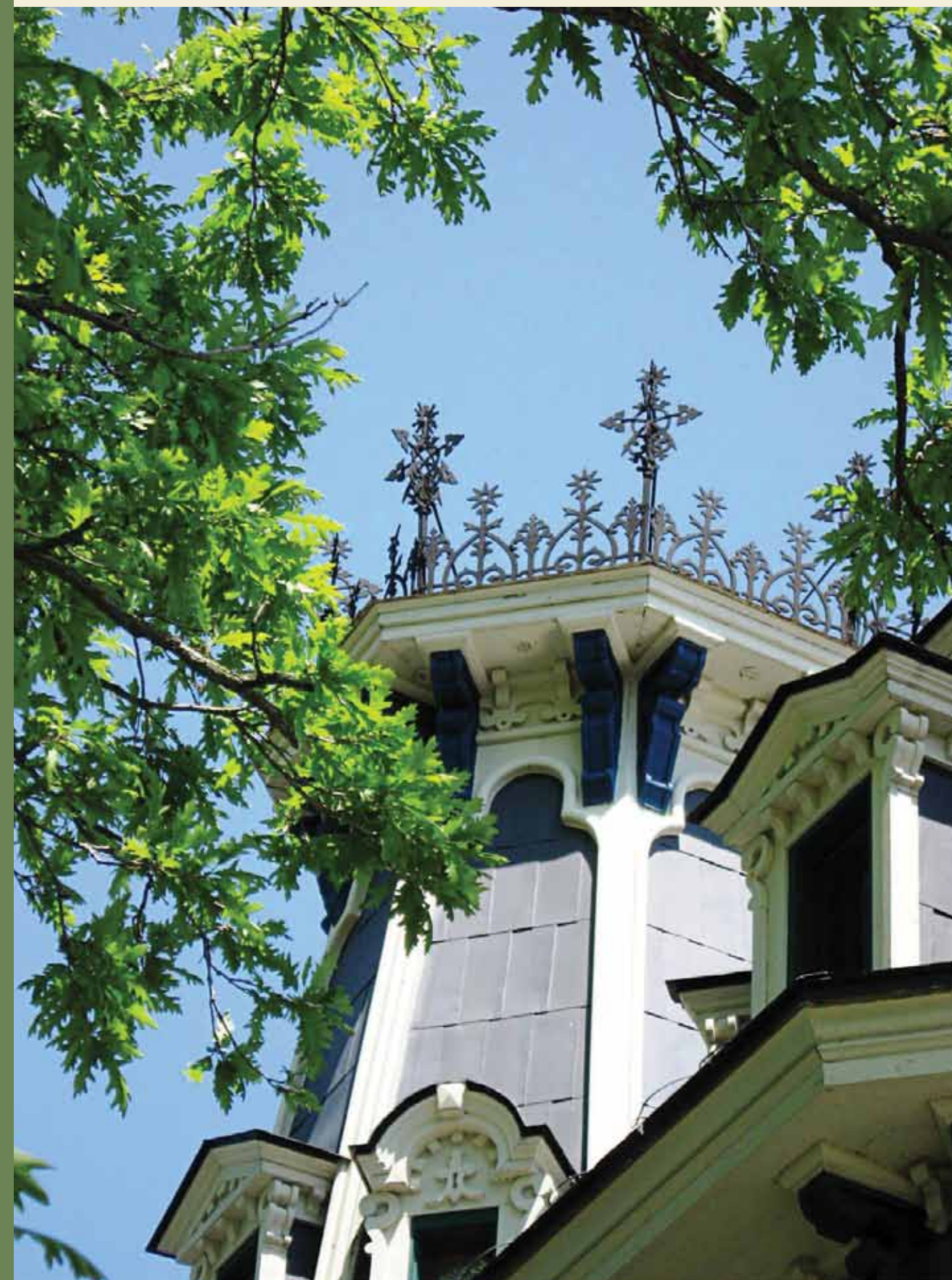
La crête faîtière – le garde-corps en métal ouvragé qui couronne le toit octogonal – est typique de l'architecture Second Empire. © Diane Joly, 2015
