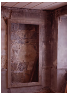
Vestiges d'une armoire encastree dans le mur.
