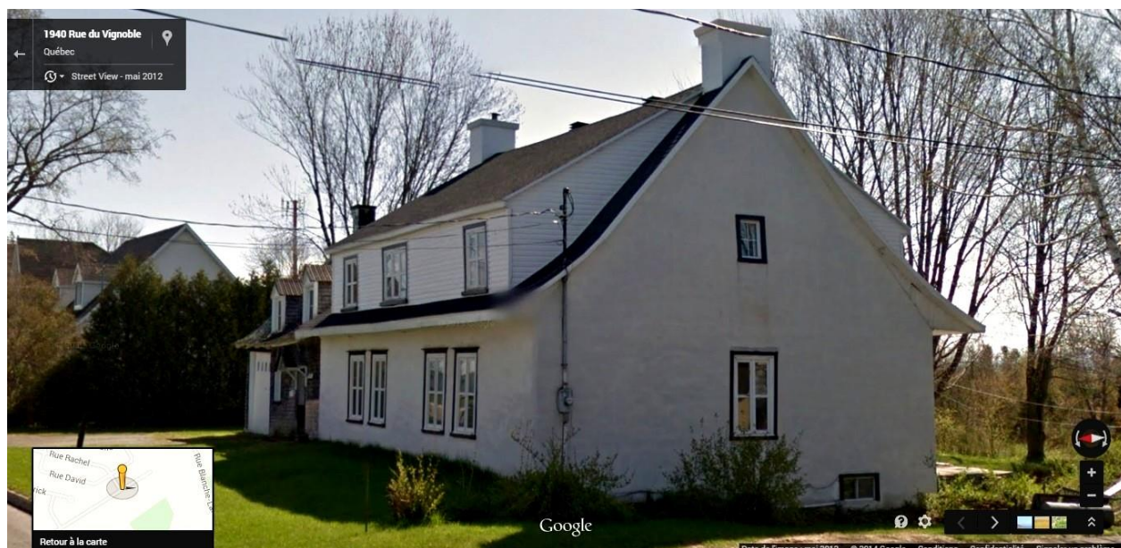
Vue arrière d'une maison du XVIII e siècle sur la rue du Vignoble
