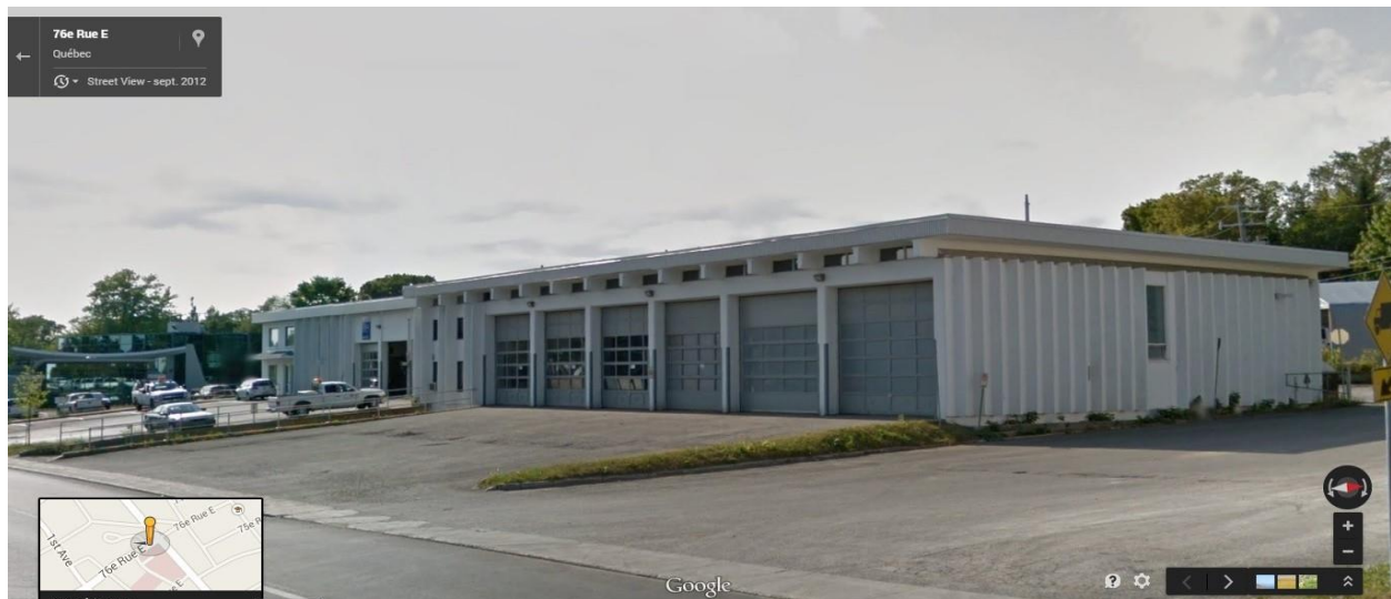
Le garage municipal vu de la 76 e rue Est
