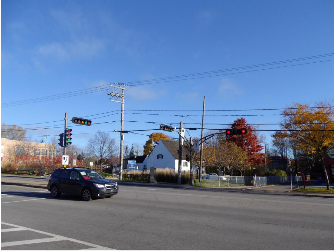
Les fils électriques à l'entrée du Moulin des Jésuites, sur le boulevard Henri-Bourassa
