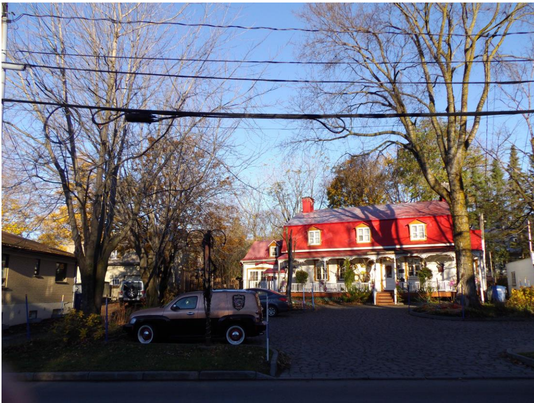
Les fils électriques devant la maison Bédard-Doucinet, au 319, Louis-XIV Ouest
