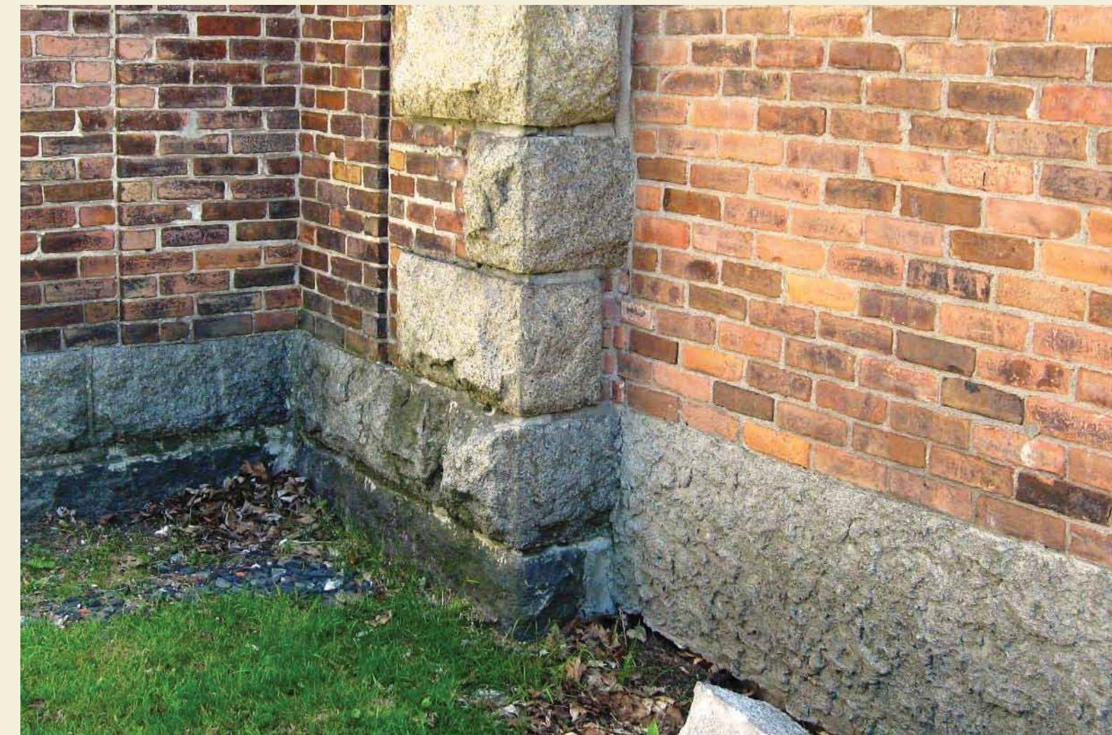
Les différences dans la maçonnerie de briques et le soubassement révèlent des périodes de construction distinctes.
